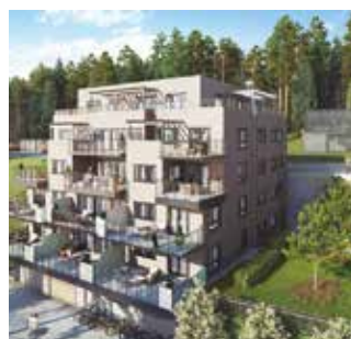
Nowa wspólnota mieszkaniowa Bergås Terrasse w Drammen, Norwegia. ECOi / Aquarea
