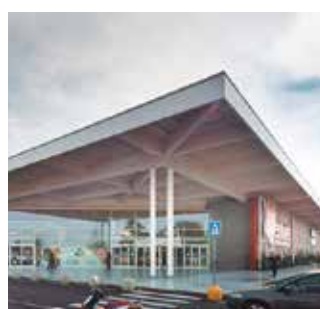
Centrum handlowe Le Centurie Centro Commerciale o powierzchni 40 000 m 2 ; 40 lokali użytkowych (Padwa, Włochy). ECOi
