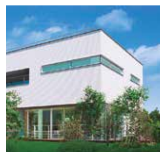
Inteligentny dom na wyspie Ariake w Tokio. Branża ogrzewania, wentylacji i klimatyzacji w połączeniu z solarnym wytwarzaniem mocy, ogniwami paliwowymi i akumulatorami.
